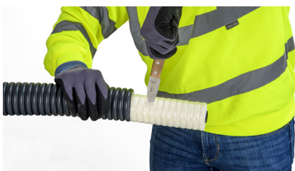
5 Fjern isolasjonen over den markerte lengden (X, Y, Z).
