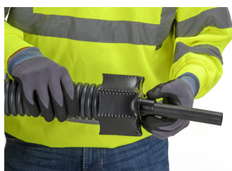
7 End cap krympes nøyaktig på plass, iht. vedlagte Raychem DHEC monteringsveiledning.
