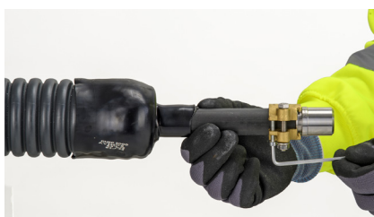
8 Installer kobling iht. vedlagte monteringsveiledning.
