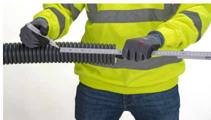
1 Marker avstand (x, y, z) + 1 cm fra enden av røret
