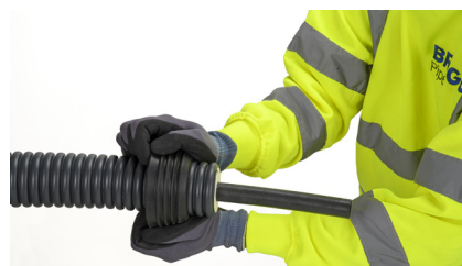
6 Monter veggpakningen.
