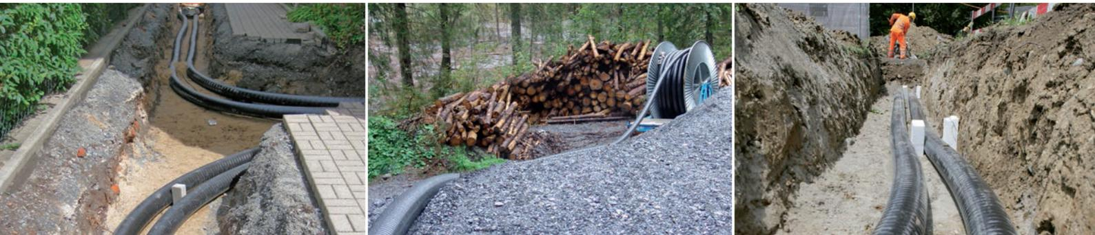
Lange leveringslengder og et svært fleksibelt rørsystem forenkler rør-traseen
